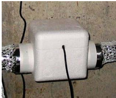
遠隔表示式水道メーター防寒カバーの一例
